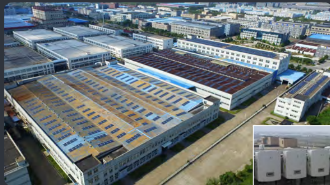
Hangzhou Bay EGL | 600kW
